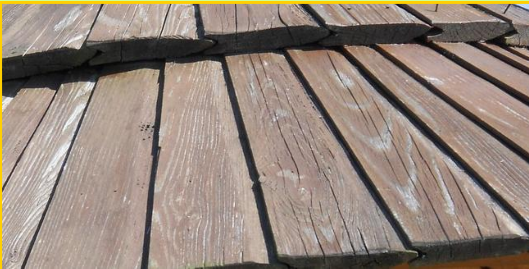
Detail skládání šindele
